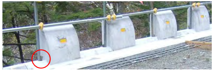
単管が動かないようキャンバーで固定
