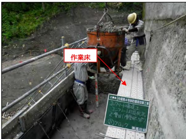
挿入筋を利用した作業床の設置
