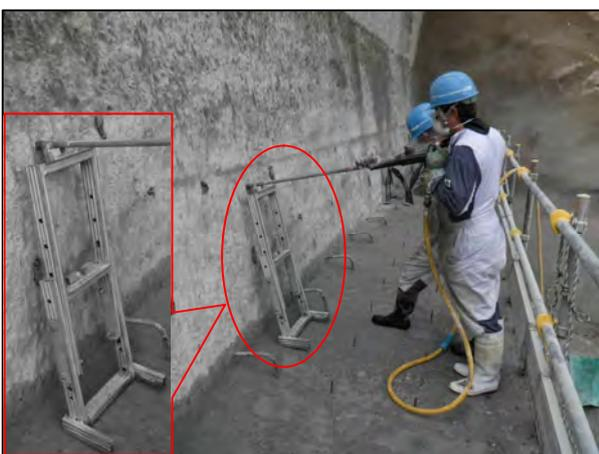
補助器具を使用した削孔状況【写真-5】
