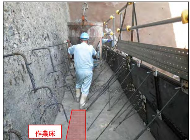
挿入筋加工による作業床の確保
