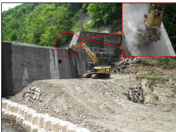
コンクリート切削機械によるチッピング【写真-3】
