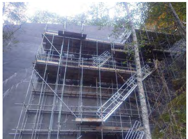
図 3.3 リフトオフ足場仮設状況
