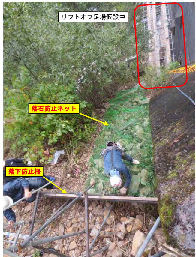
図 3.2 リフトオフ足場上部の落石防止対策
