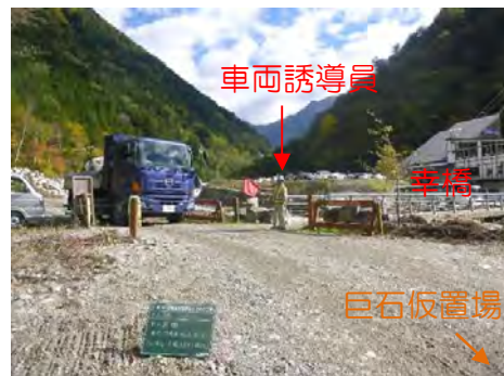
－工事用車両誘導員配置状況－
