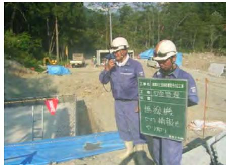
・場内では、クレーンオペレータと職長に雷探知機・風力計を携帯させ、計器の警戒ブザーが鳴った場合は、拡声器にて現場作業員に知らせ退避させた。
