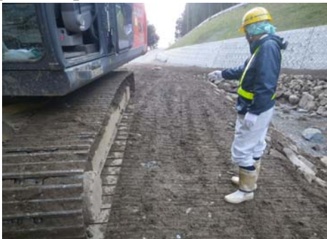
【写真10】 重機足場 ヨシ!!
