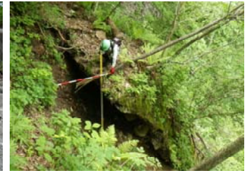
土砂吸い出し
