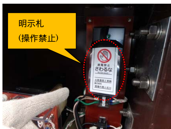
写真3（明示札取付状況）
