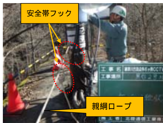
写真2 (安全帯使用状況)
