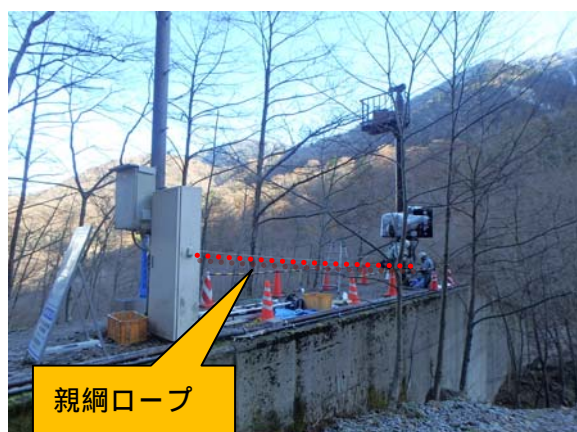
写真1 (親綱ロープ設置状況)
