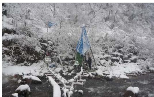
写真 2.2.1. 跡津川地区：河道内作業の状況
