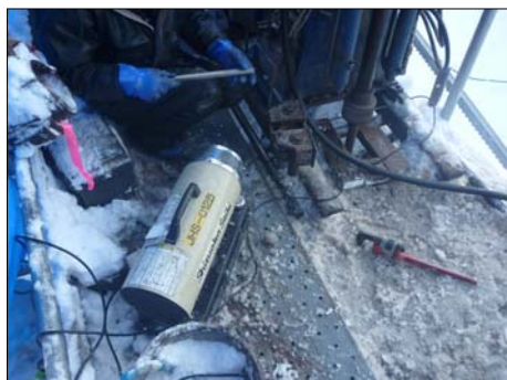
ジェットヒーターによる機器類の解氷作業
