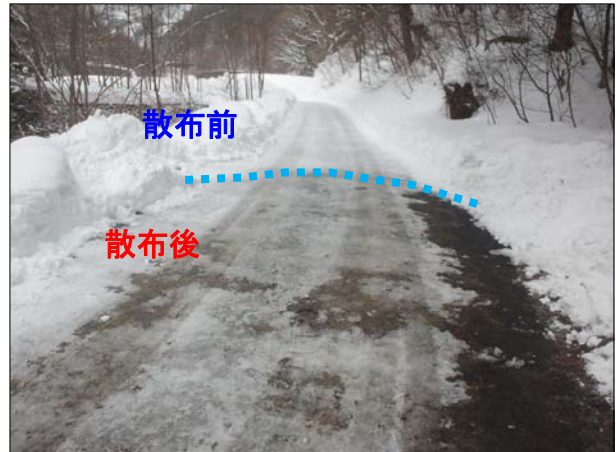
融雪剤（塩化カルシウム）の散布。散布後、効果確認。
