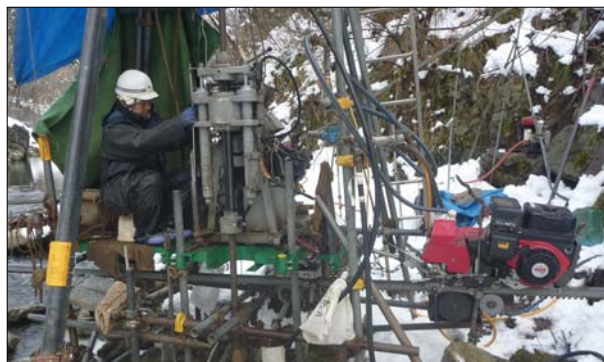
写真 3.3.1. モノレール台車一体型移動式ボーリングマシン
