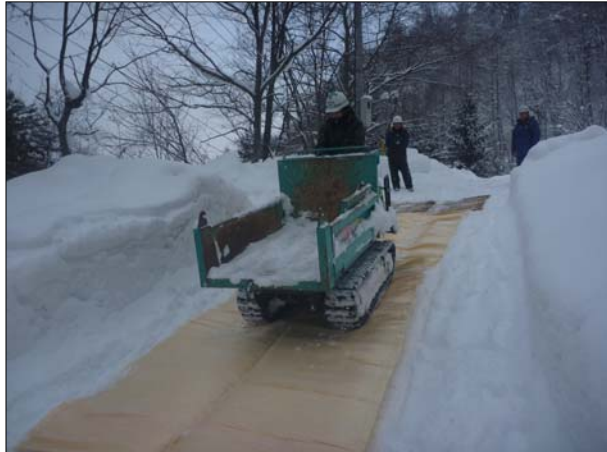
特装車の運搬道路に筵（むしろ）を敷設
