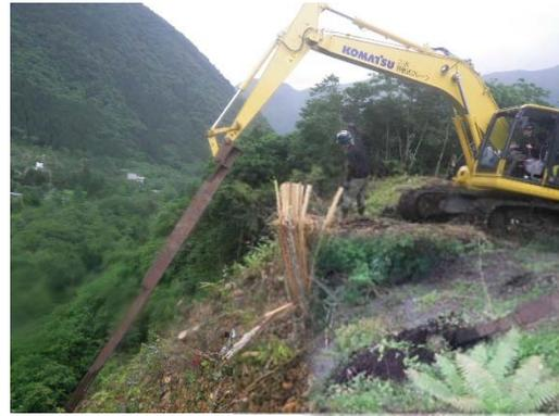
写真6 切崩しの機械化
