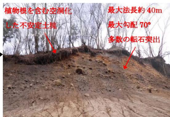
写真3 崩壊斜面の様子
