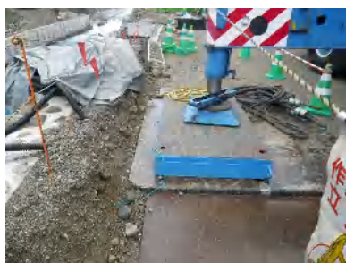
北陸電力から実施依頼事項 クレーンにアース線設置
