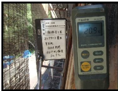
〔写真-9 外気温及び簾内部温度測定〕
