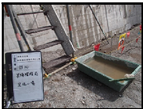
〔写真-5 昇降設備前足洗い場設置〕
