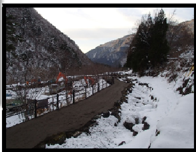
しのぶ工区 施工中
