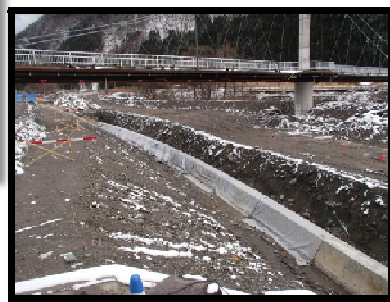
平湯川砂防樹林帯工区 施工中
