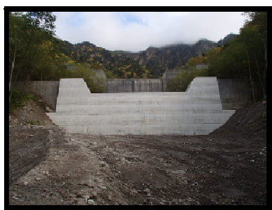
餌掛谷工区 完了
