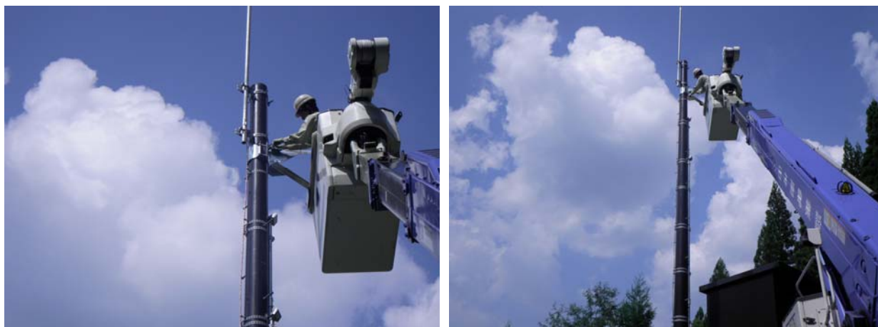
【写真 9、10 高所作業車を使用した機器据付状況】
