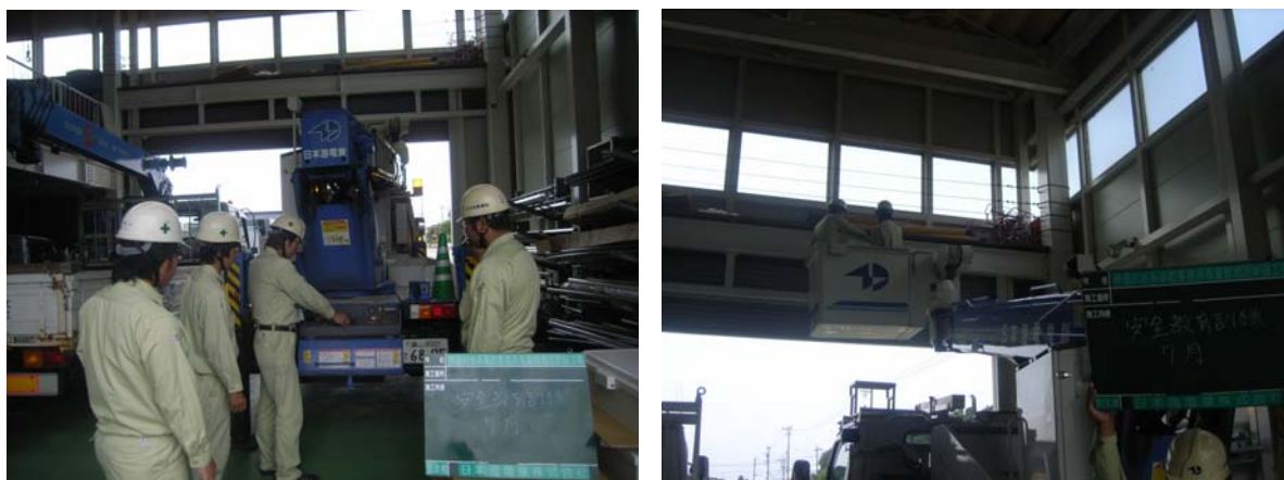
【写真5、6 安全教育訓練 高所作業車操作実践訓練状況】
