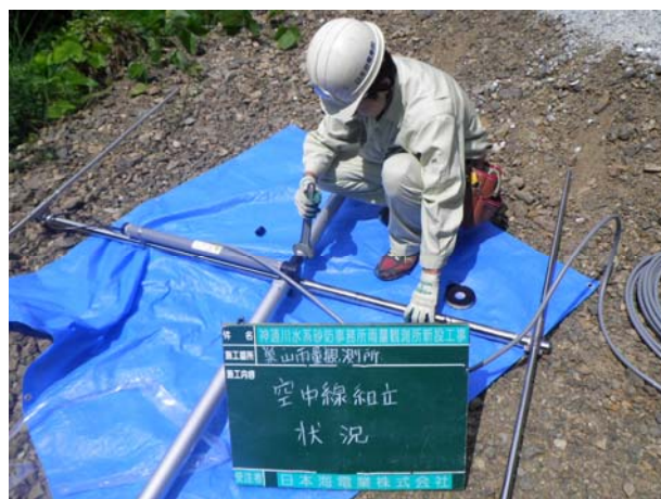
【写真4 地上での空中線組立状況】
