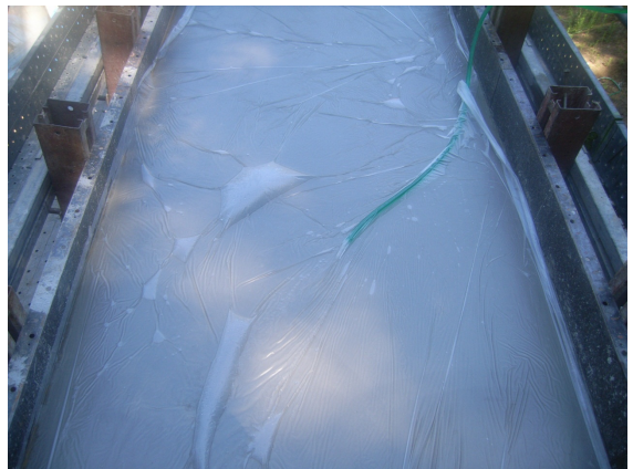
コンクリート天端養生状況
