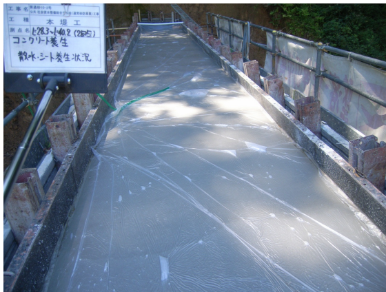
コンクリート天端養生状況
