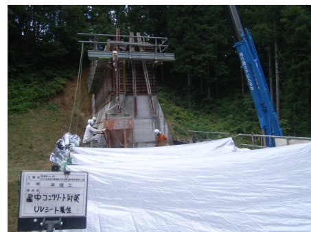
UVシートによる打設養生状況
