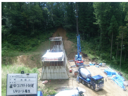
UVシートによる打設養生状況
