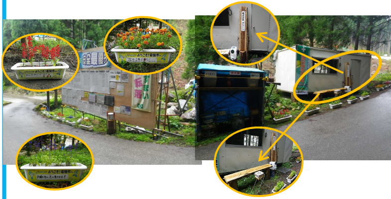
【写真16】 現場事務所周辺の美化
