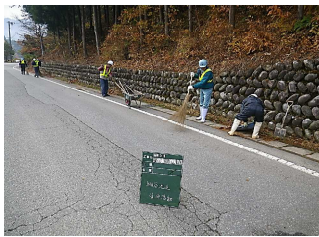
【写真12】 清掃状況
