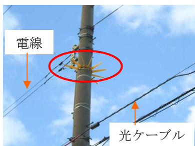
写真3. 柱上昇り過ぎ防止器 ⇒器具が頭に当たり 器具以上昇れない
