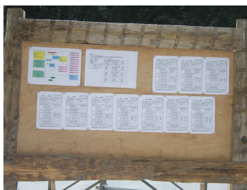
安全掲示板(現場内)
