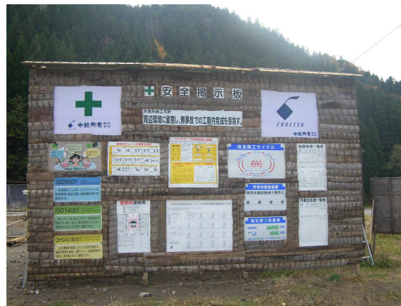
安全掲示板(現場事務所)
