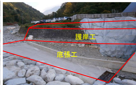
(今年度施工箇所上流側)
