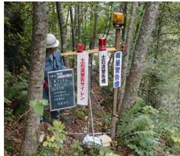
第9号砂防堰堤
