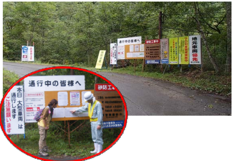
登山者への工事説明と注意喚起（割谷ゲート）
