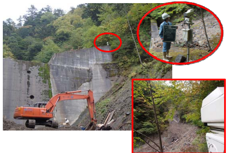
監視カメラ②（第9号堰堤上流全景）
