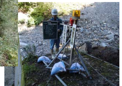
第5号砂防堰堤下流
