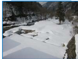
施工箇所残雪状況
