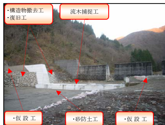
下流より施工箇所を望む (工事完了)
