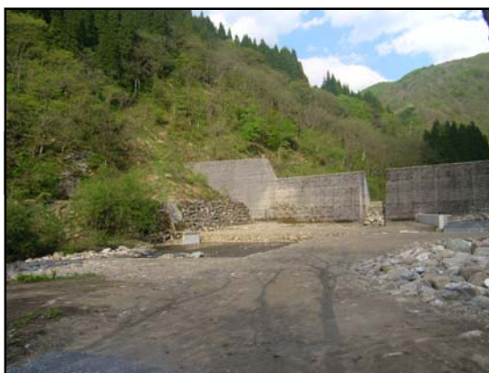
下流より施工箇所を望む (工事着手前)
