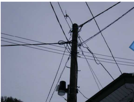
事務所外の 風速・雨量・外気温・気圧計測器
