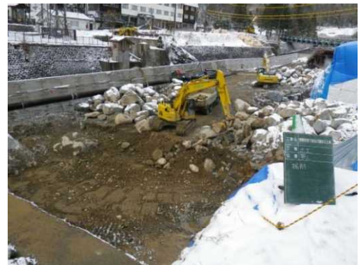
・柵越しの施工風景
