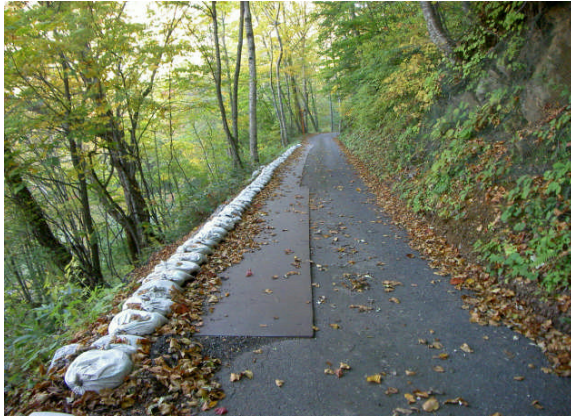
← ① 崩壊仮復旧箇所
