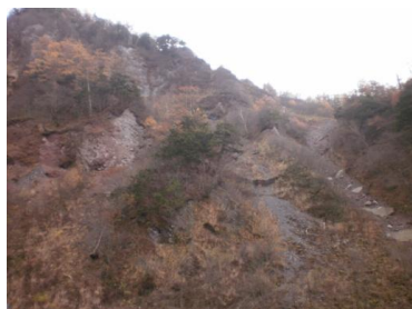
〔写真-2 左岸側崩壊状況〕
