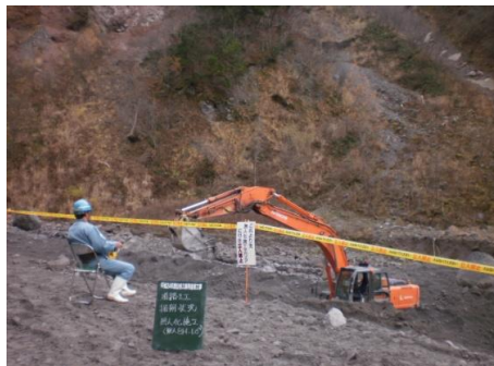
〔写真-4 遠隔操作式バックホウ使用〕
