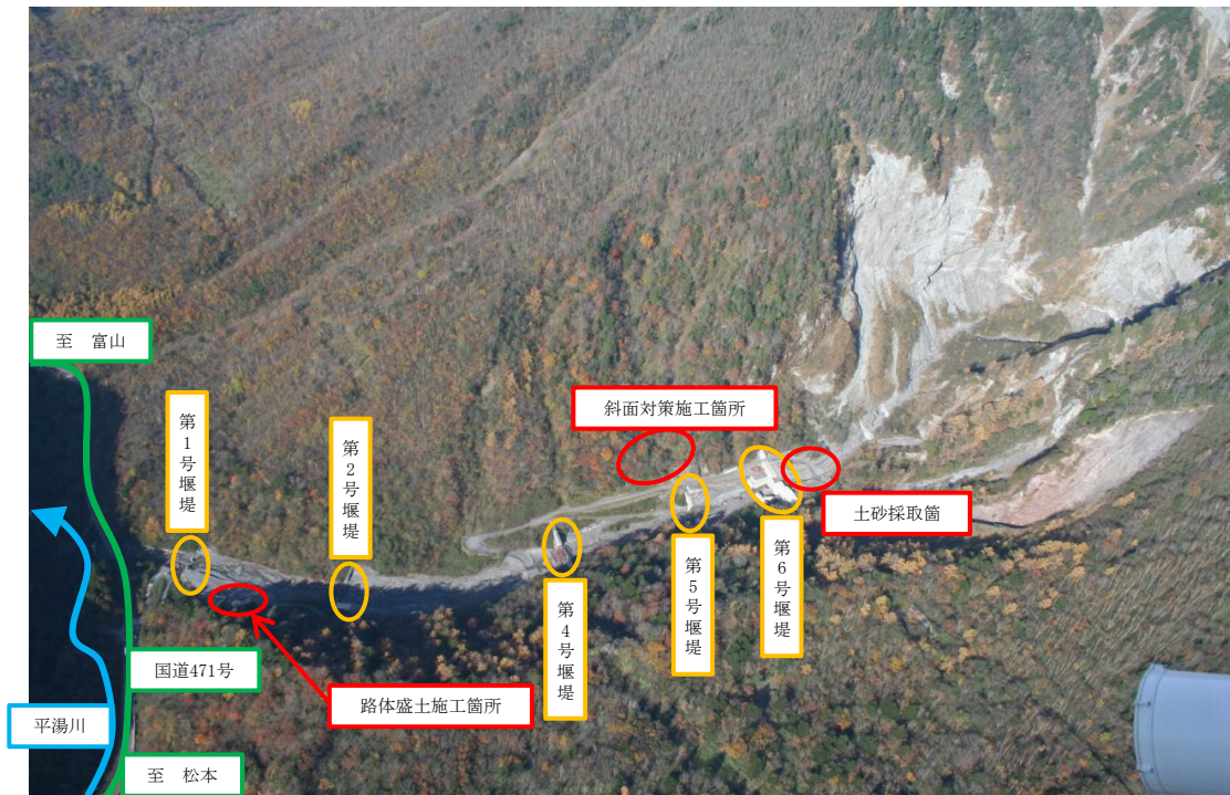
[写真-1 白谷全域 上空より白谷を望む]
