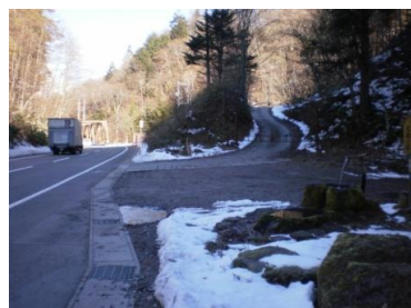
〔写真-3 現場出入口〕
