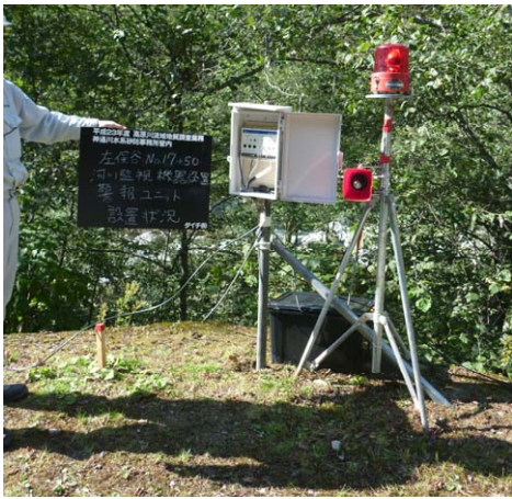
写真 3.3.5. 警報機・回転灯・サイレン設置
