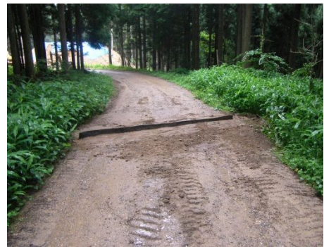
写真2. 簡易水路の設置
