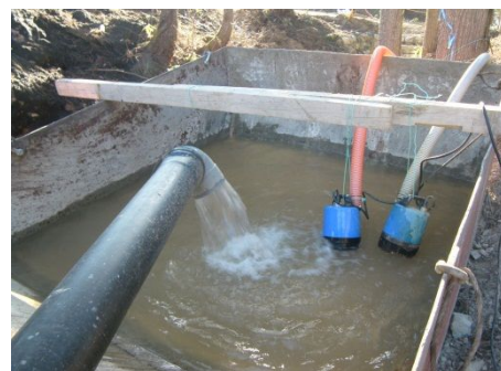
写真2. 2次沈砂池設置状況
