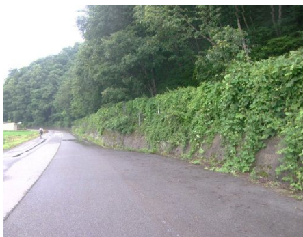
写真3. 施工箇所付近の除草作業(着工前)
