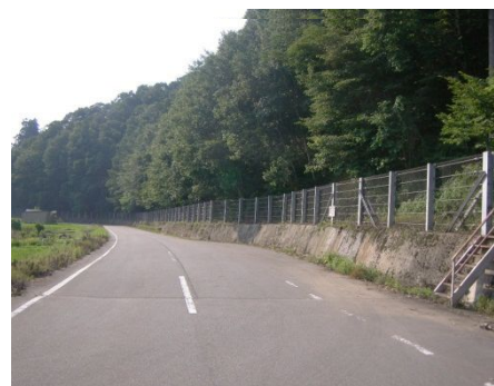
写真4. 施工箇所付近の除草作業(着工後)
