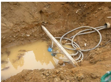
写真1. 1次沈砂池状況
