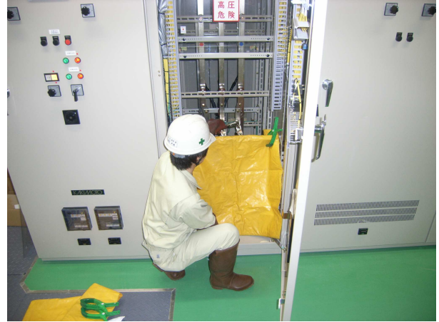
絶縁シート使用状況
