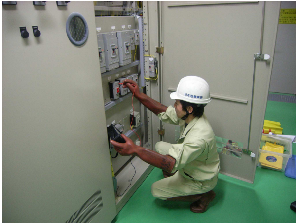
電圧測定確認
