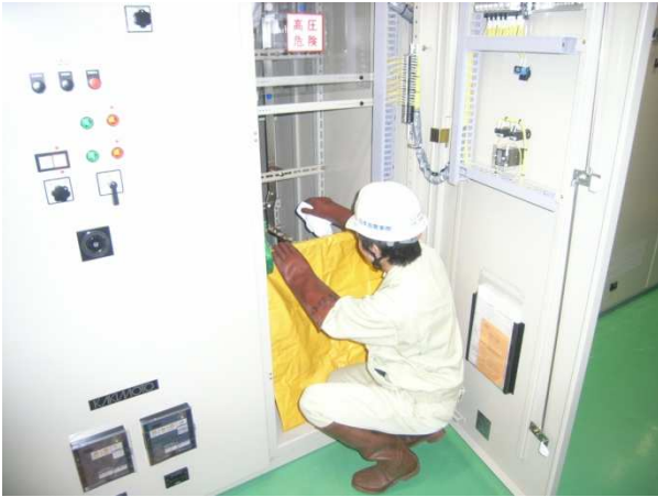
絶縁シート使用状況
