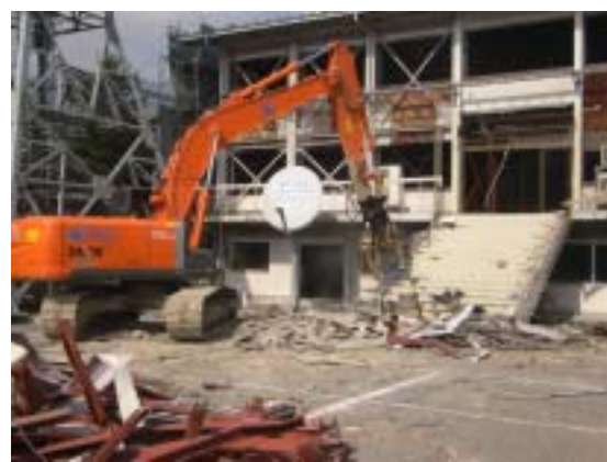
油圧式コンクリート圧砕機
