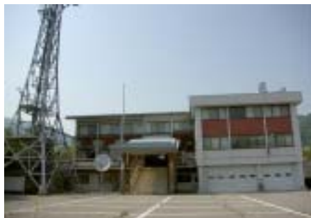
着工前 旧庁舎
