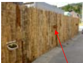
間伐材による仮囲い
