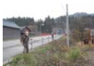
現場周辺の草刈り
