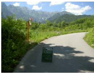
カーブミラー設置
