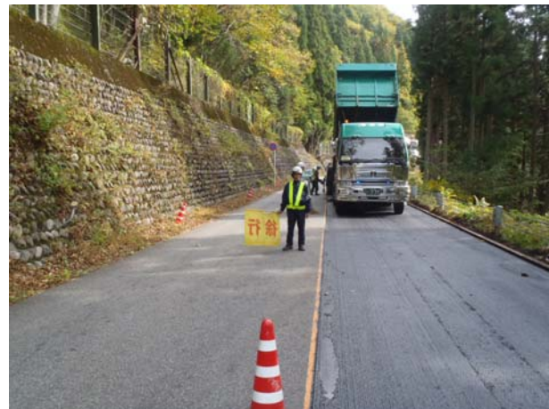
施工箇所に誘導員の配置。
