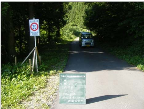
速度制限表示板の設置状況
