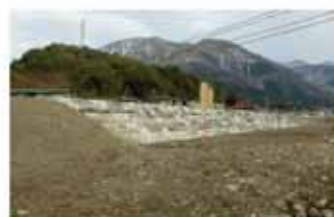
導流堤の施工状況
