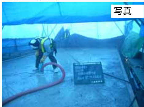
打継目処理作業中ポンプによる汲み上げ
