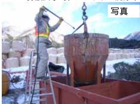
打設終了時、バケットの洗浄中
