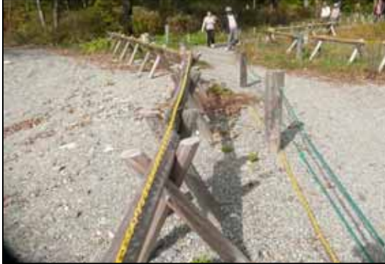
(ロープ柵・木製バリケードの二重防護柵の設置)
