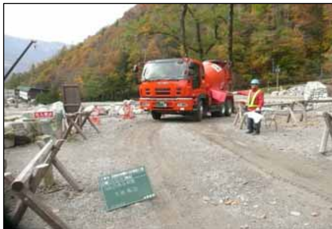
(交通誘導員の配置)
