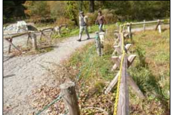
(ロープ柵・木製バリケードの二重防護柵の設置)
