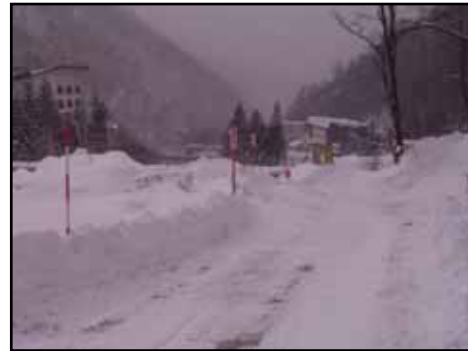
除雪時の目印として、工事用道路の路肩部にはポールを設置。
