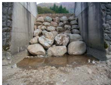
本堰堤スリット部(下流)
