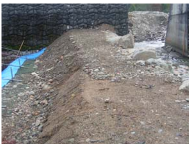
本堰堤～副堰堤間
