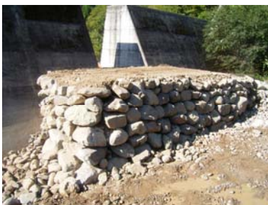
本堰堤スリット部(上流)
