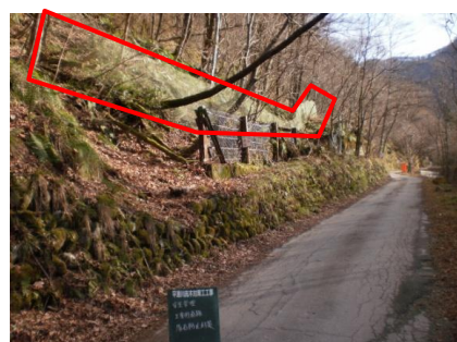
落石防止網 (2) 設置 L=60m
