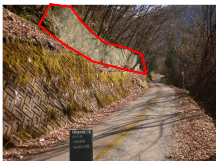
落石防止網 (1) 設置 L=40m
