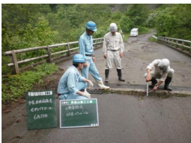
工事用道路点検状況
