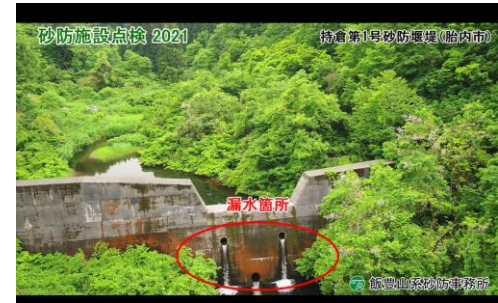
UAVによる砂防施設の 点検映像の紹介
