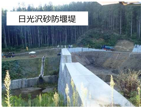
堰堤直上流の河道内土砂掘削中
