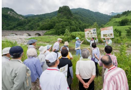
玉川スーパー暗渠砂防堰堤を見ながら、砂防堰堤の効果について説明しました。
