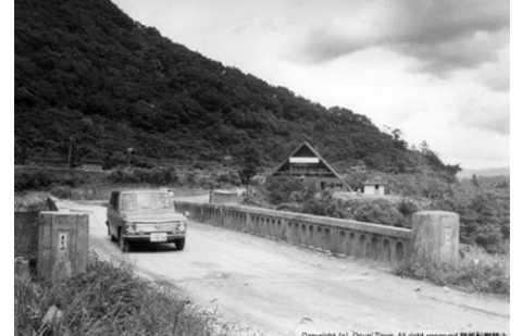
水害前の赤芝橋の様子。当時はドライブインも隣接していました。
