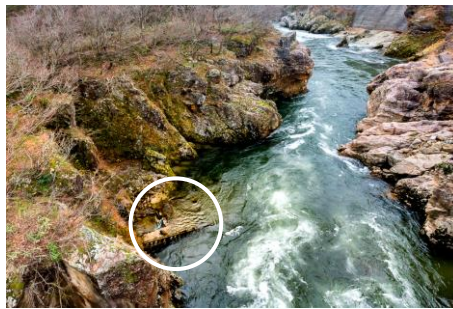
このような形で、橋桁は今も荒川に残されています（白丸の箇所）。
