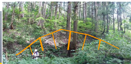
写真-上流溪岸部の崩壊状況
