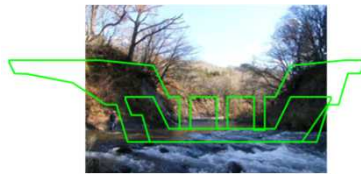
写真-施工箇所
