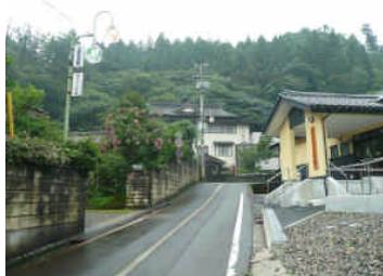
羽越水害土砂災害被害箇所 関川村湯沢地区の状況
