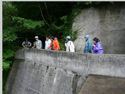
砂防堰堤の働きを現場で学ぶ（飯豊山系砂防事務所）
