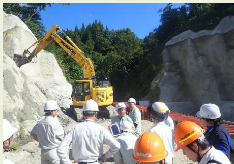
実際に使用中のICT建機を見学
