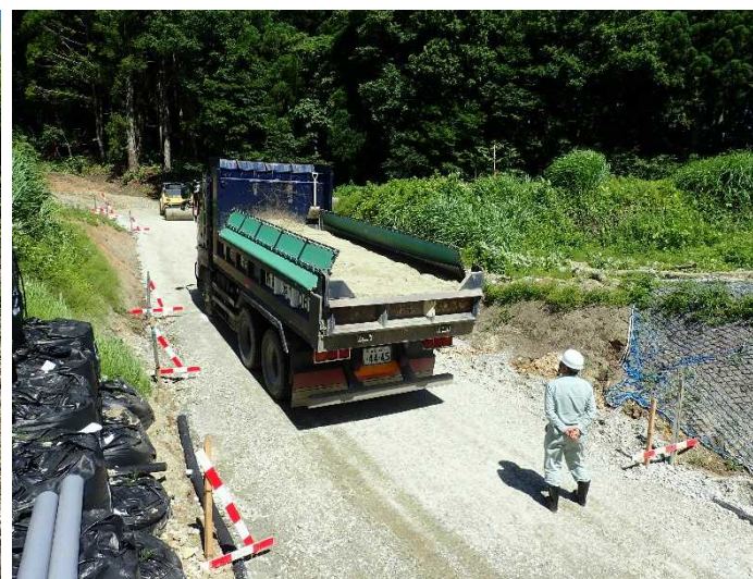
路盤のプルフローリング確認状況(R5年6月)
