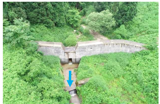
着手前の西山川砂防堰堤 (撮影：R5年6月)
