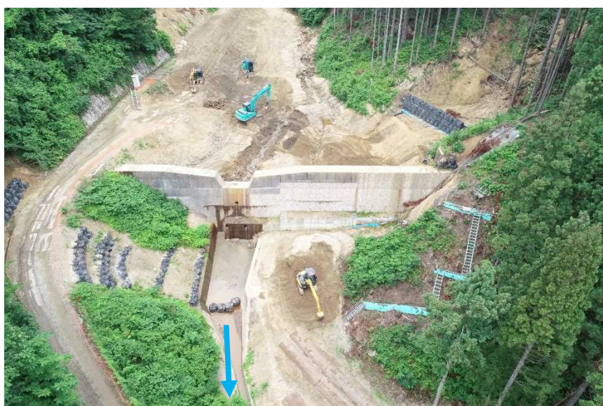
現在は土砂・流木の撤去などを 実施しています。 (撮影: R5年6月)
