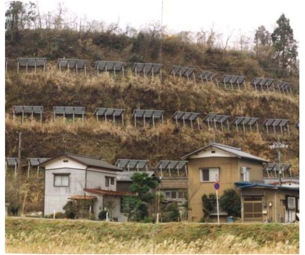
■予防柵工（雪崩の起きそうな斜面の積雪を受け止め、雪崩を防ぐ施設）
