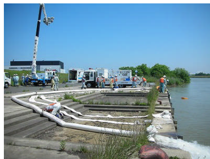
排水ポンプ車を使った排水訓練
