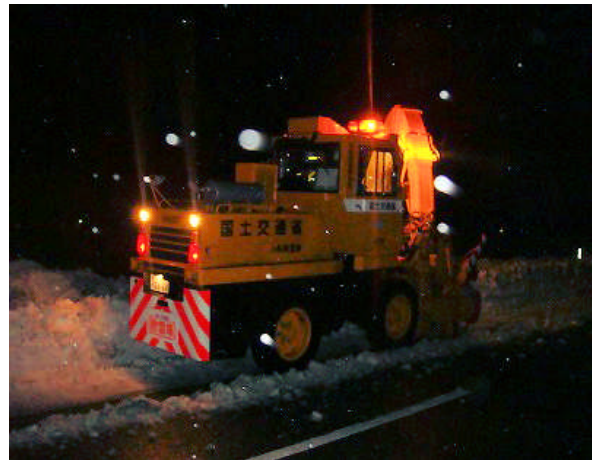
拡幅除雪作業（注2）
