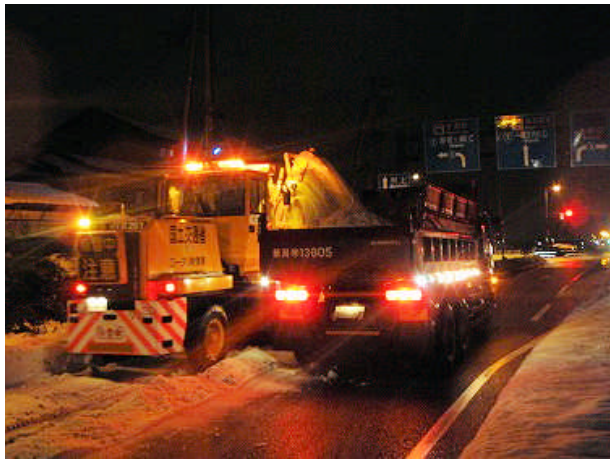
運搬排雪作業（注1）
