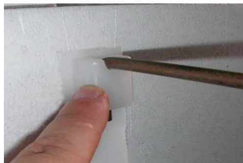
写真 - 4 改良型セパレーター留
