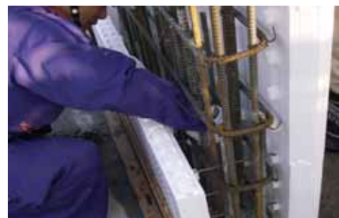
写真 - 3 型枠組立状
