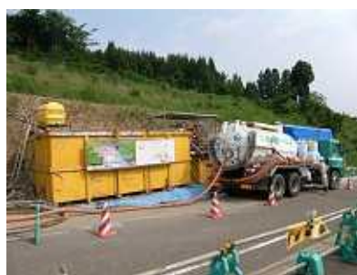
写真 - 9 汚泥吸引車搬出
