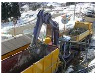
写真 - 8 ダンプ搬出状況
