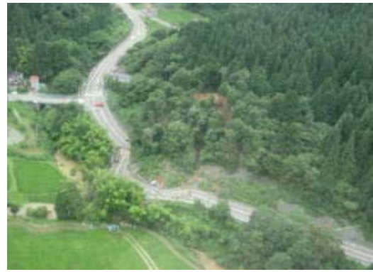
新潟県中越沖地震の道路被災状況
