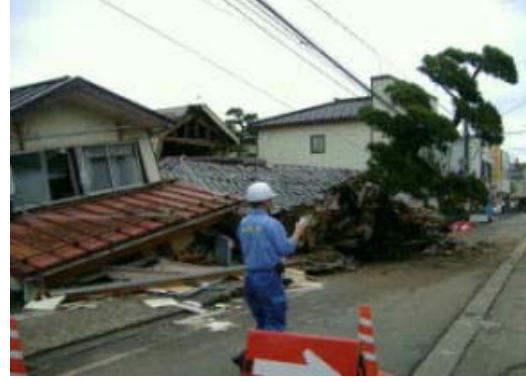
新潟県中越沖地震の家屋被災状況
