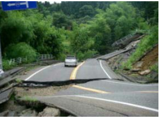
新潟県中越沖地震の道路被災状況
