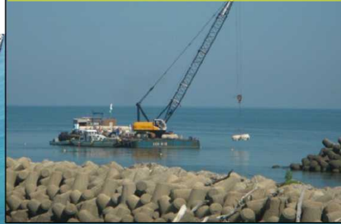
クレーン付き台船によるブロック据付作業
